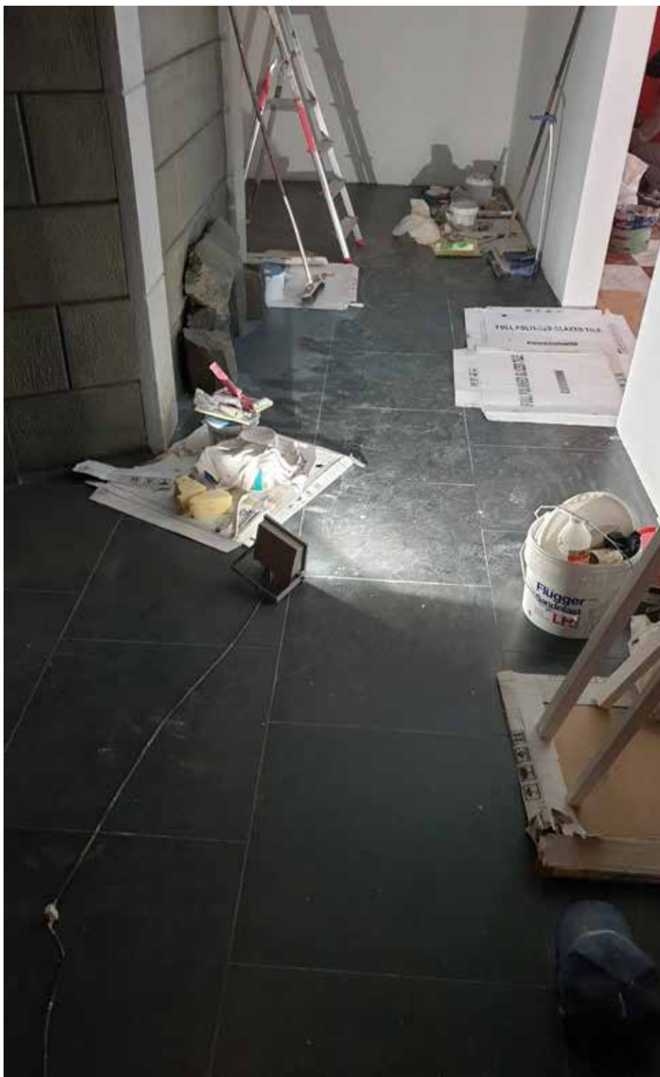
Framkvæmdir við nýja salinn.
