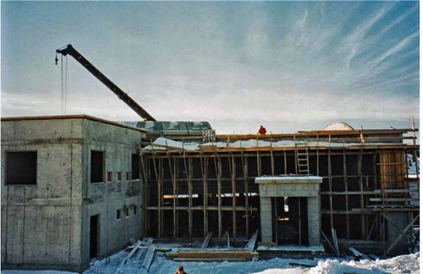
Ljósatröð í byggingu.
