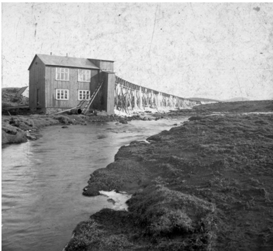
Mynd: Byggðasafn Hafnarfjarðar
