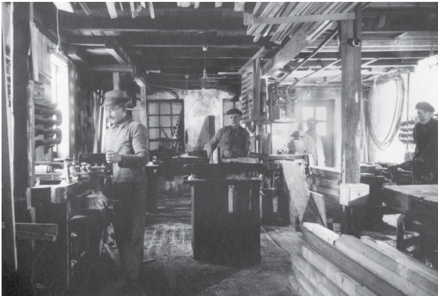
Mynd: Byggðasafn Hafnarfjarðar
