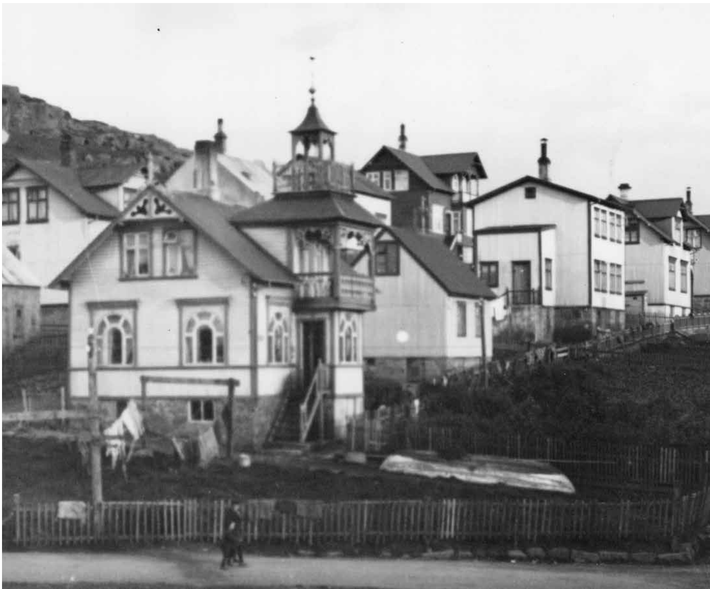
Mynd: Byggðasafn Hafnarfjarðar
